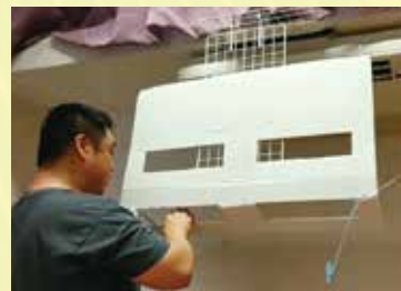
冷氣擋板： 格子網+發泡膠板+膠夾+繩+鋼扣
